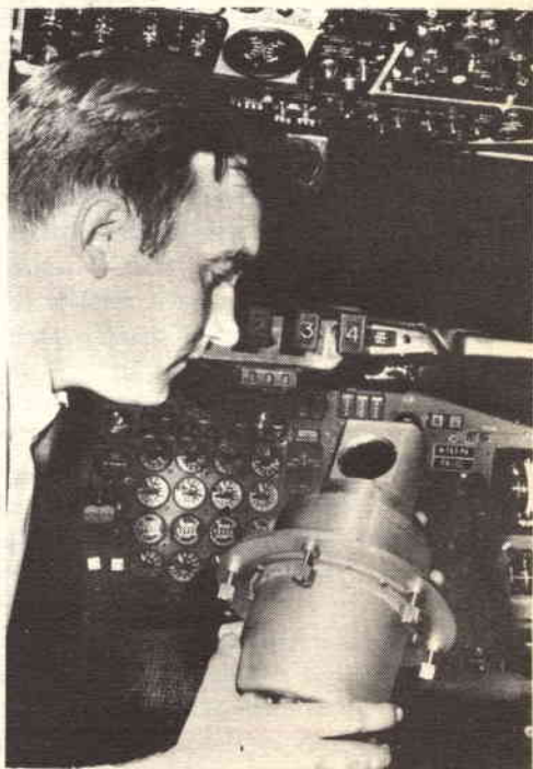
Testata sensibile del sistema infrarosso della Barnes, per localizzare i CAT, montata nella cabina di un Boeing 707 della Pan American.
